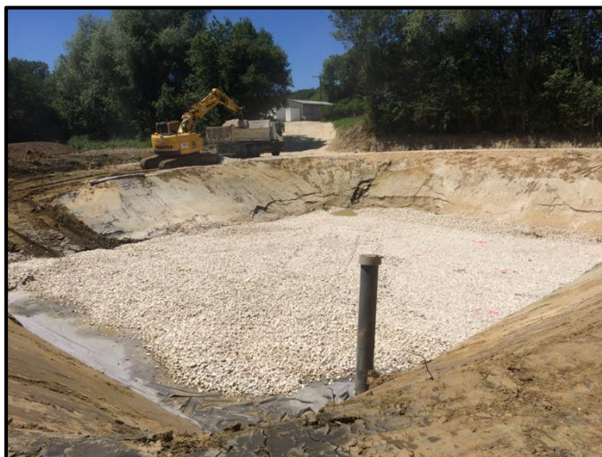
Figure 10 : Terrassement de la station de Parly
