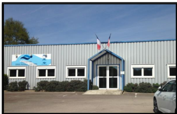
Figure 19 : Siège de la Fédération et lieu d'accueil de la Régie
